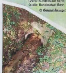
Bislang fließt der Holtorfer Bach teilweise im Rohr. FOTO: STAAT BONN
