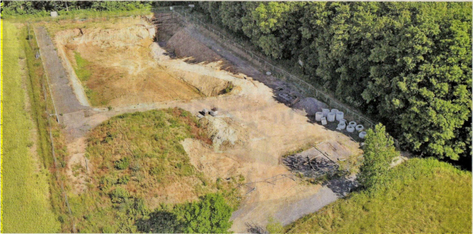
Wann die Bauarbeiten am Bodenfilter oberhalb des Holzlarer Sees wieder aufgenommen werden, ist noch ungewiss.
